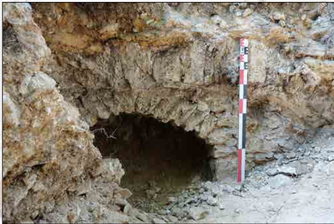
Arcade murée de la cave 2 - cliché Akane Hori
